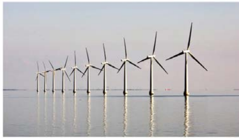
Speicher für Windenergie: So funktioniert die größte Batterie der Welt
